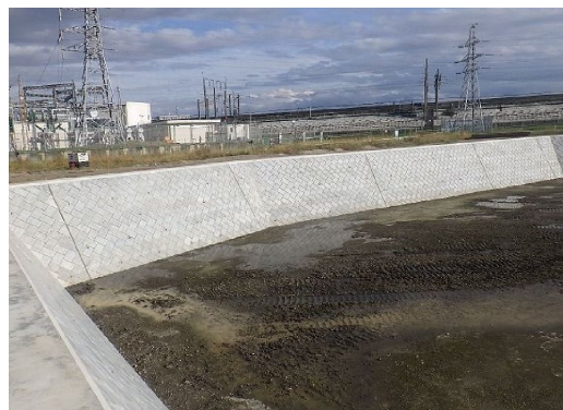
写真 8.4-2 (2) 調整池イメージ (大型ブロック積擁壁)
