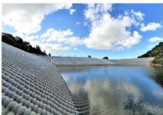
写真 8.4-2 (1) 調整池イメージ (布製型枠)
