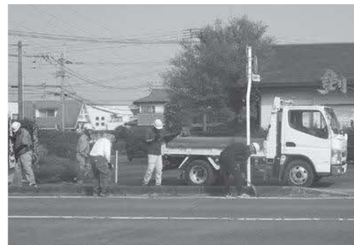
道路側溝の清掃作業
