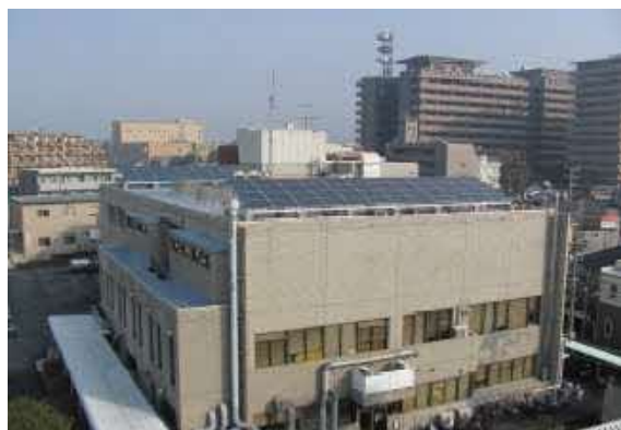
太陽光発電（上下水道局別館）
