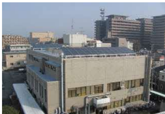
太陽光発電 (上下水道局別館)
