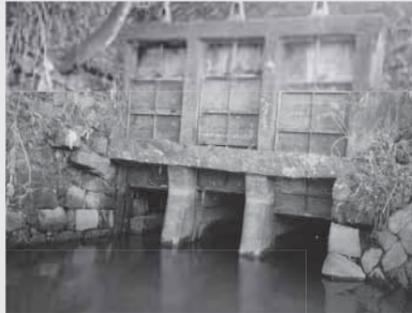
この取入口は、加藤清正による治山治水事業の一つであり、慶長13年(1608)白川下流域の左岸を水田化するため、馬場楠に白川の水を取り入れる堰を設け新たな井手を掘削したものです。この取入口は、何度か修復され、現在は部分的にコンクリートで補強されていますが、昭和28年の白川大水害にも耐え、今もなお健在です。
