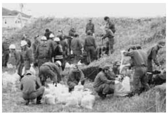
▲土のうは、水や土砂の移動を妨ぐ効果があります
