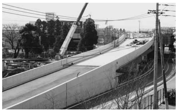
▲建設が進む横道合志2号線（図書館から撮影）
