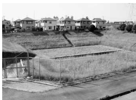
▲石坂調整池(都市部の雨水処理施設)
