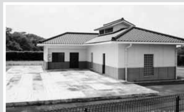
▲白水浄化センター(農業集落排水事業) 処理対象人口:1,030人 受益戸数:217戸
