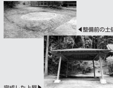
完成した上屋▶
