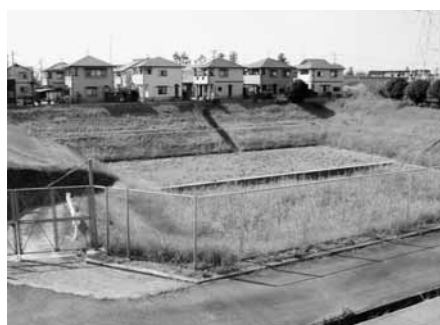
▲石坂調整池(都市部の雨水処理施設)
