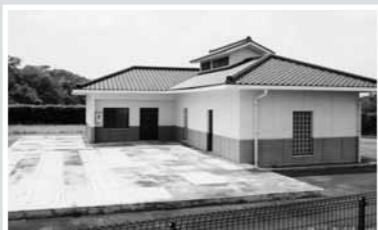
▲白水浄化センター(農業集落排水事業) 処理対象人口:1,030人 受益戸数:217戸
