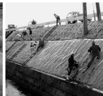
▲防草シートの設置
