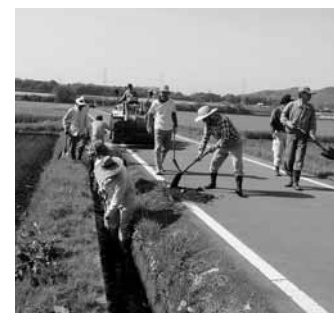
▲水路の泥上げ
