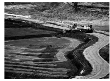
▲農地の災害復旧現場
