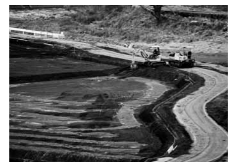
▲農地の災害復旧現場
