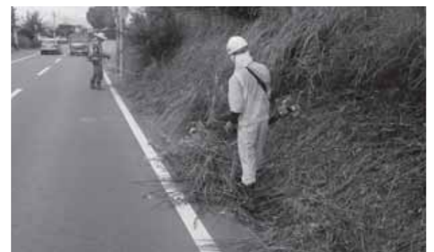
▲暑い中清掃作業する菊陽町土木建設業協会の会員
