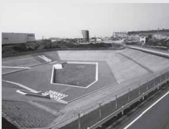
▲ハンズマン菊陽店周辺の土地約58%の雨水を処理する久保第一雨水調整池
