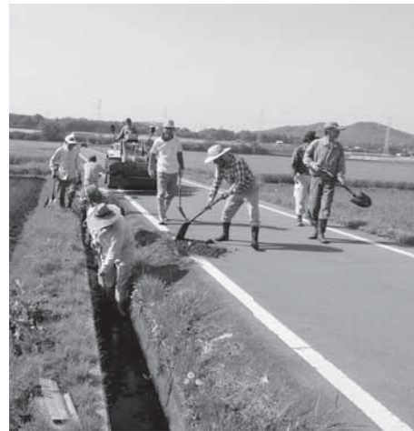
▲水路の泥上げ
