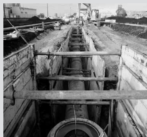
▲雨から町を守る雨水排水管用設置工事の様子
