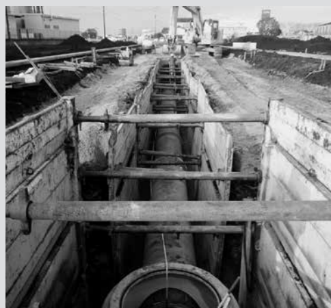
▲雨から町を守る雨水排水管設置工事の様子
