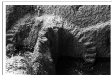
削った厚く固い岩盤を地上へ持ち出すときのための階段が残る鼻ぐり井手
