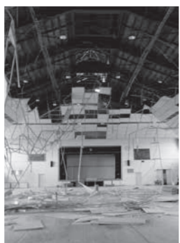
▲このような被害が起こらないよう、耐震対策工事を行います
