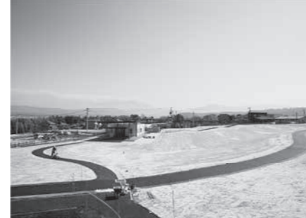
▲工事が進む鼻ぐり井手公園。今秋完成予定
