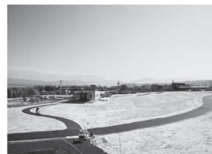
▲工事が進む鼻ぐり井手公園。今秋完成予定
