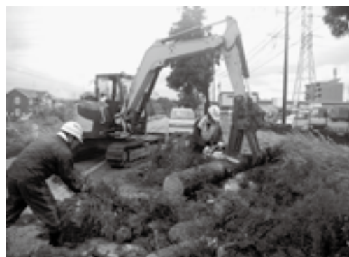
復旧作業が進む県道熊本菊陽線。通行止めも起きましたが迅速な対応で復旧しました
