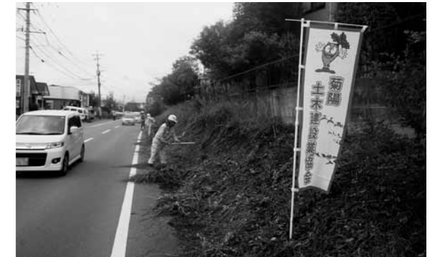
▲車道にはみ出す雑草やごみを除去する土木建設業協会
