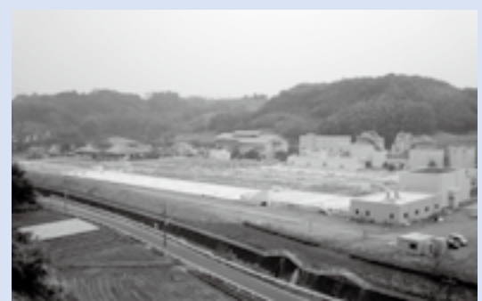
▲町内から排出された污水の最終処理場である熊本北部浄化センター
