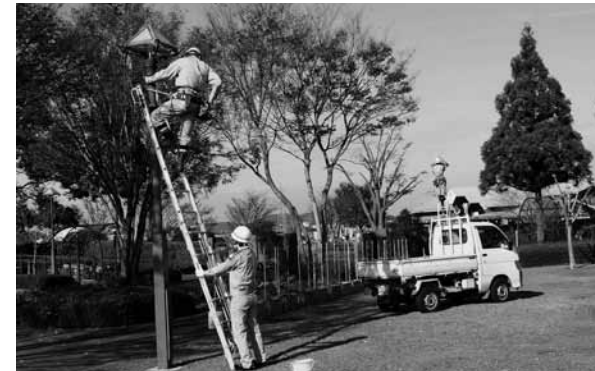
▲照明設備を丁寧に清掃する大津営業所の社員
