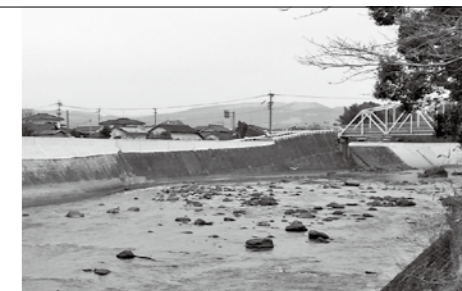
河川工事が行われた馬場楠地区
