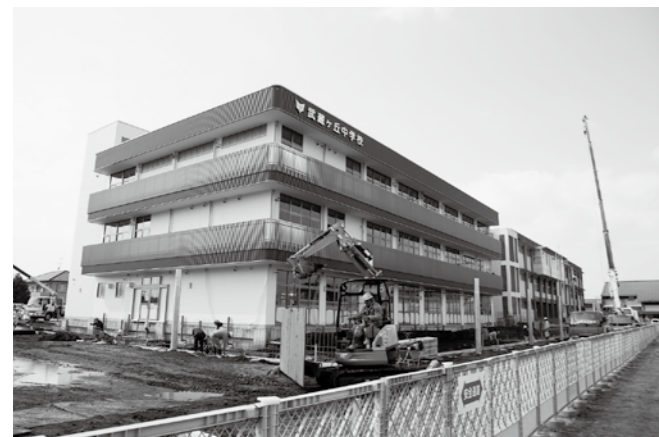
武蔵ヶ丘中学校の増築工事
