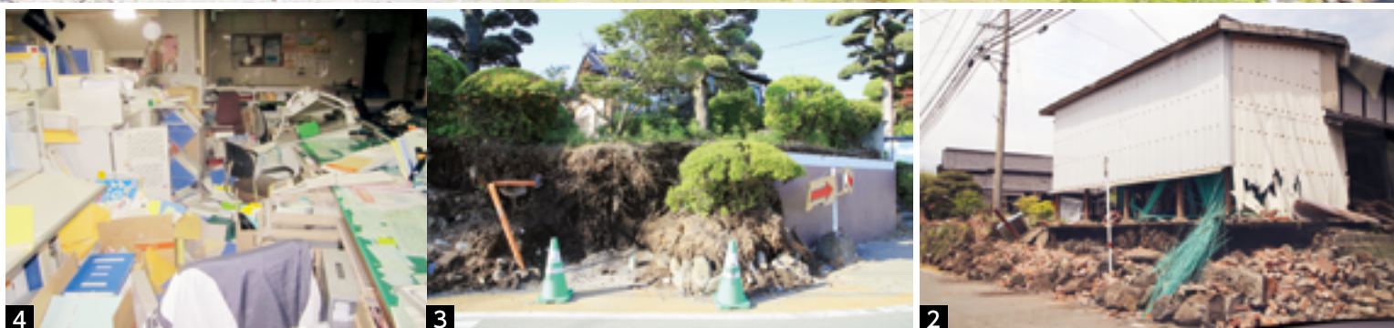
1 家の柱や基礎など全体的に傾いた家屋。住民は避難し、全員無事 2,3 家屋や小屋のブロック崩壊 4 役場の事務室内。キャビネットから書類が落下し、足の踏み場のないほど散乱した
