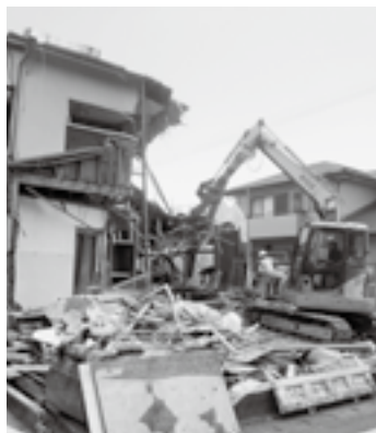
解体工事中の全壊家屋
