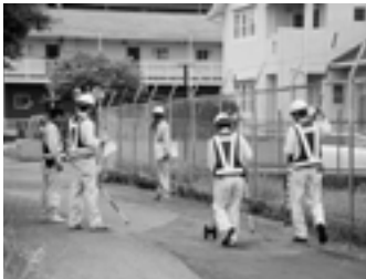
道路陥没調査
