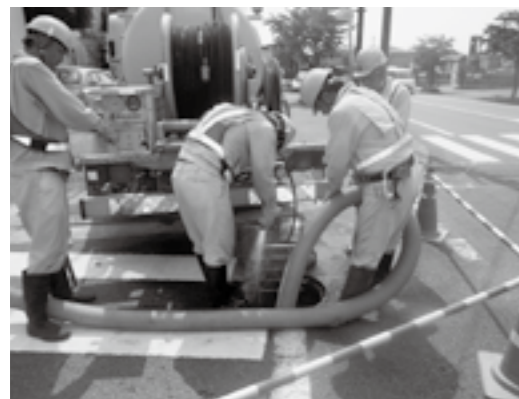
下水道汚水管の清掃 (光の森付近)
