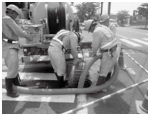
下水道汚水管の清掃(光の森付近)
