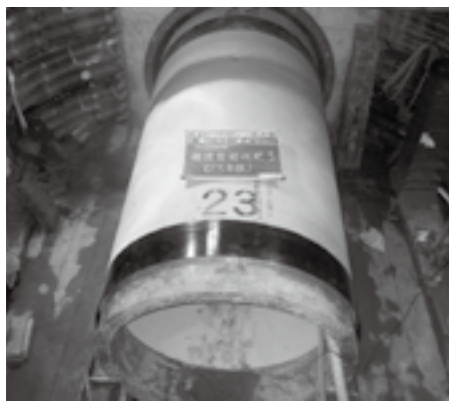
雨水管の整備(三里木付近)
