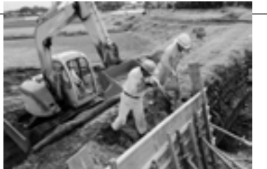
地震で崩壊した水路や農用地法面の補修などに迅速に対応します
