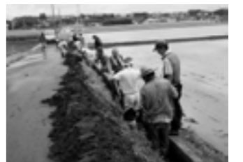
大雨で堆積した土砂の泥上げ
