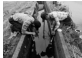
水路、側溝の目地詰めなどの補修
