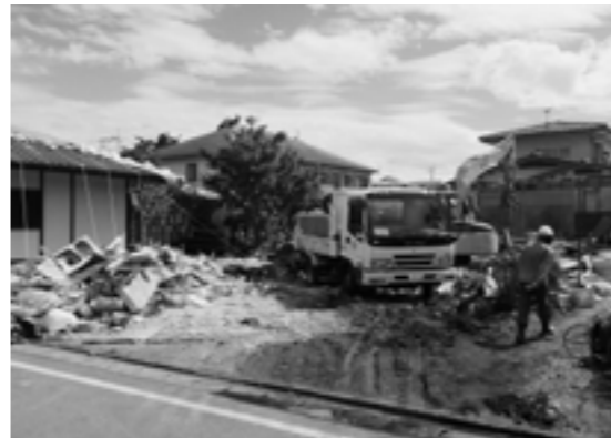
解体中の家屋
