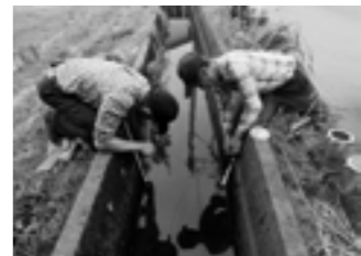
水路、側溝の目地詰めなどの補修
