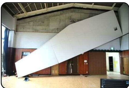
▲菊陽中学校の武道場の壁が大きく剥落
