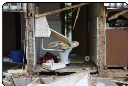
▲地震により壁が崩れ落ち、むき出しになったトイレ（柳水）
