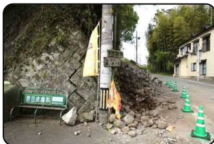
▲崩落した南小学校北側の石積み（供合線沿い）
