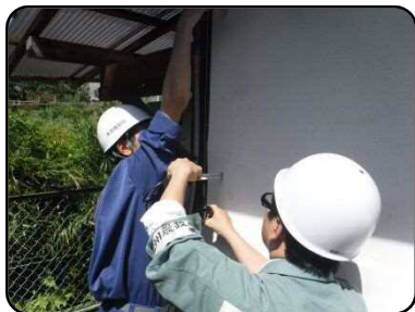
▲被害家屋の状況を確認するため、現地調査が行われた
