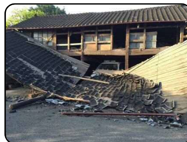
▲崩壊した納屋の屋根（辛川）
